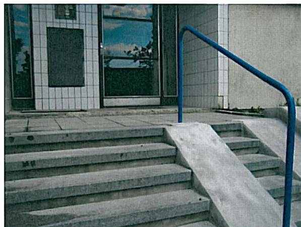
Nový stav po opravě
