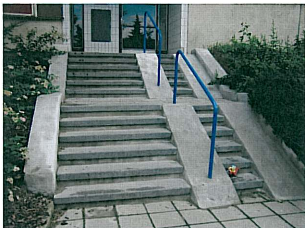
Nový stav po opravě
