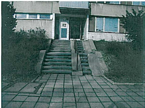
Původní stav před opravou
