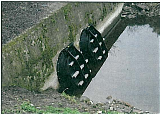
SO 06 – po osazení zpětných klapek
