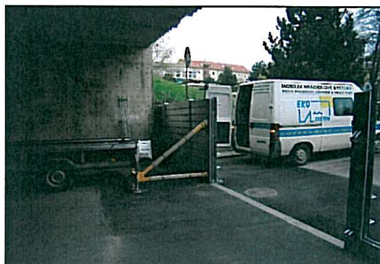
SO 05 – po osazení protipovodňových lamel
