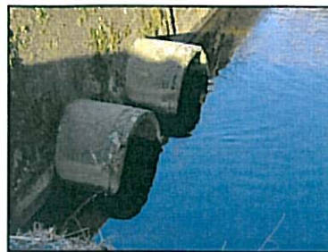
SO 06 – stav před realizací
