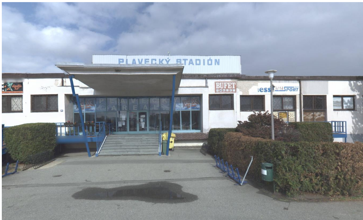
Obrázek 12: Areál, kde bude umístěn srážkoměr S1
