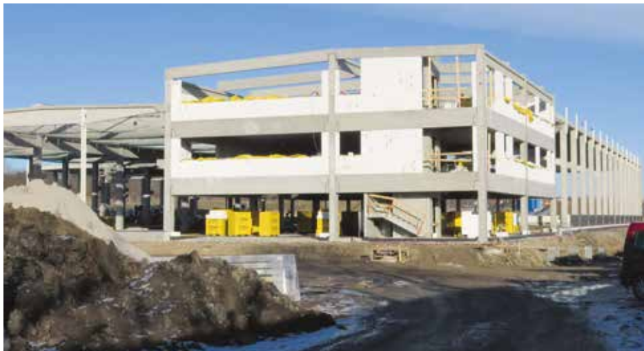
Výstavba v lokalitě Na Jelence.
