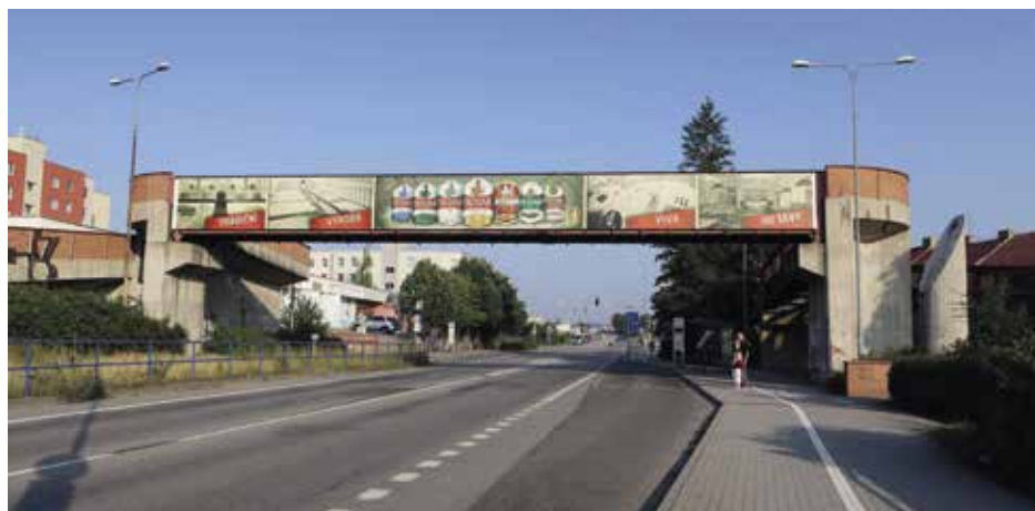
Uzavřená lávka přes Katovickou ulici
