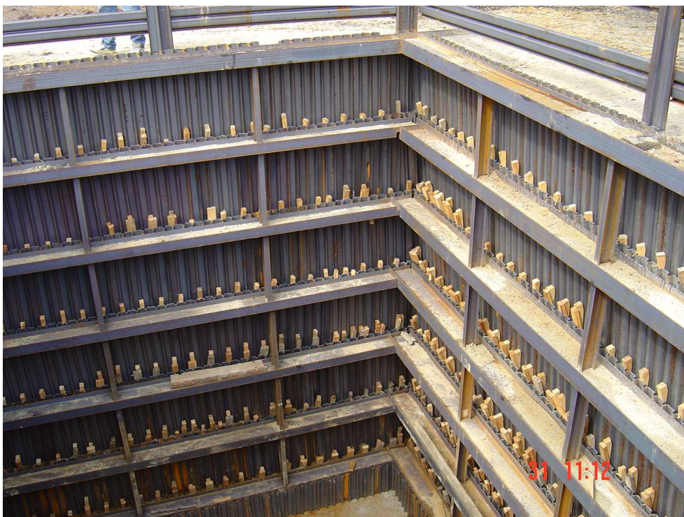
Pažení šachty Š5
