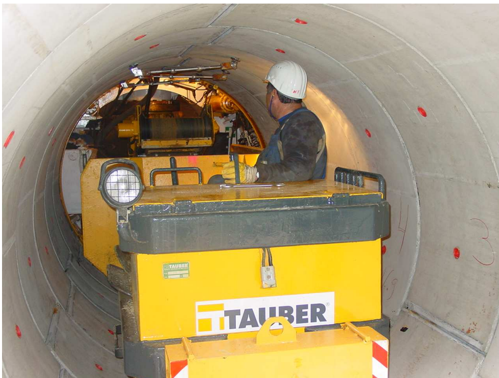
Přeprava materiálu v již vybudované štolě B
