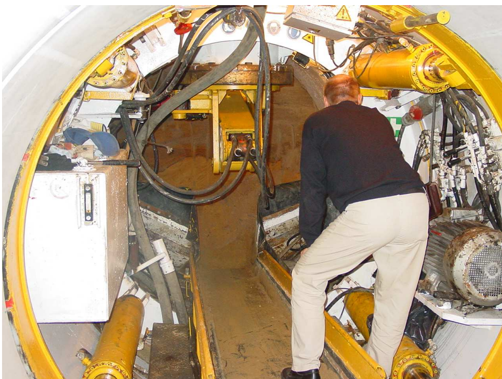
Pohled na mechanizovaný razící štít – štola B
