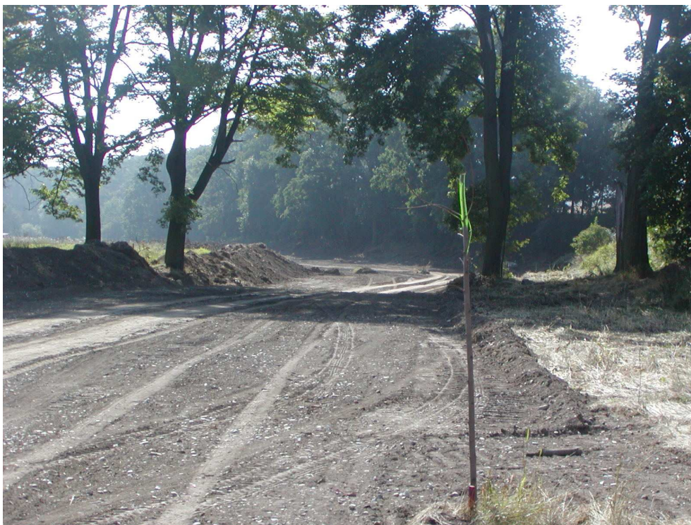
SO – 05 Uložení zeminy
