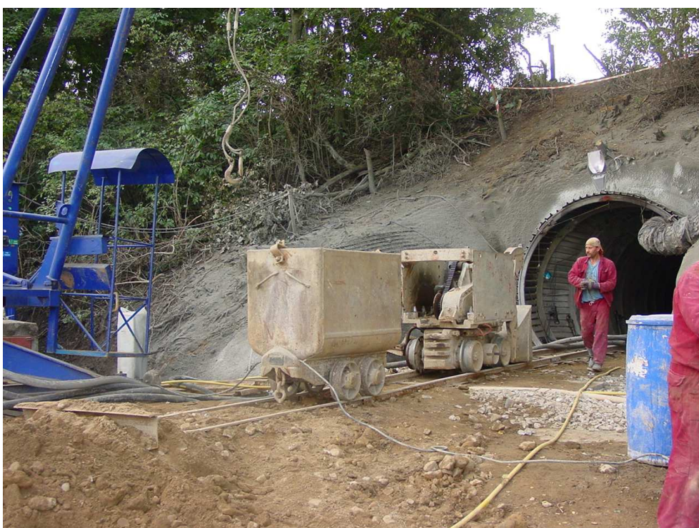
Ražba klasickou důlní technologií – štola B
