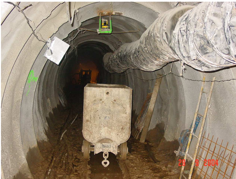
Vyztužení štoly při ražbě
