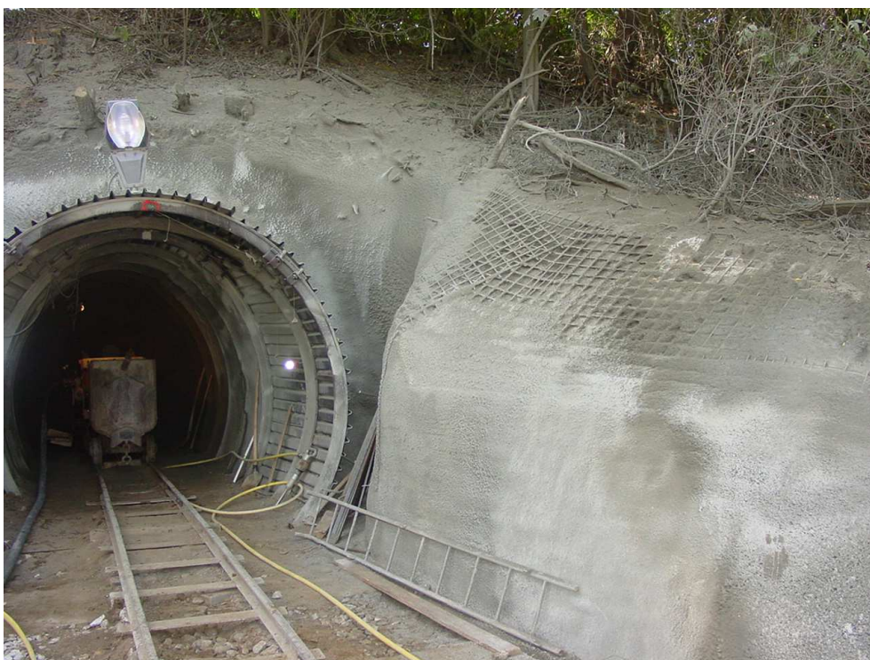
Pohled do štoly B (od ČOV)
