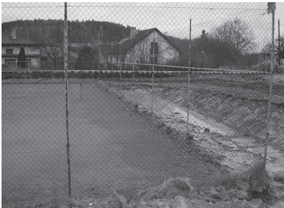
Hřiště před úpravami zaplavované především dešťovou vodou. Foto: Archiv TJ ČZ Strakonice
