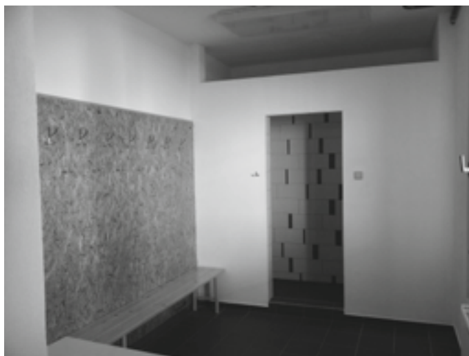
Pohled na nově vybudované šatny a sprchy.
