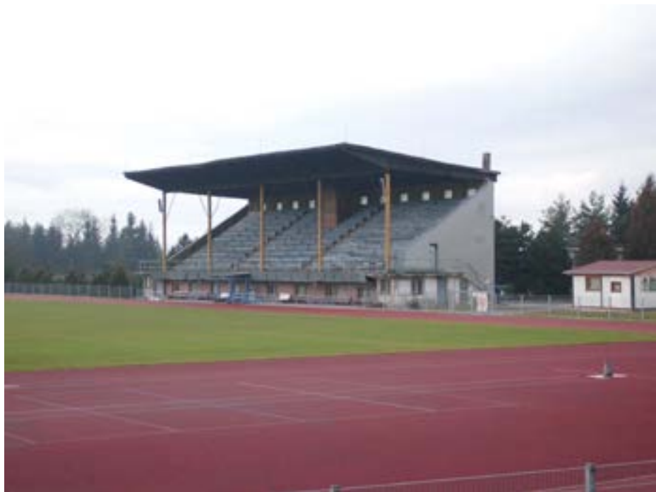
Tribuna ve Sportovním areálu Na Sídlišti ještě před opravou. Foto: archiv MěÚ Strakonice
