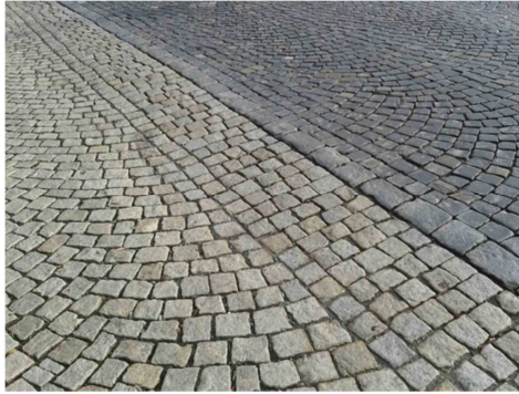
Obr. 5 – Vějířová dlažba – štípaná žula 10 cm
