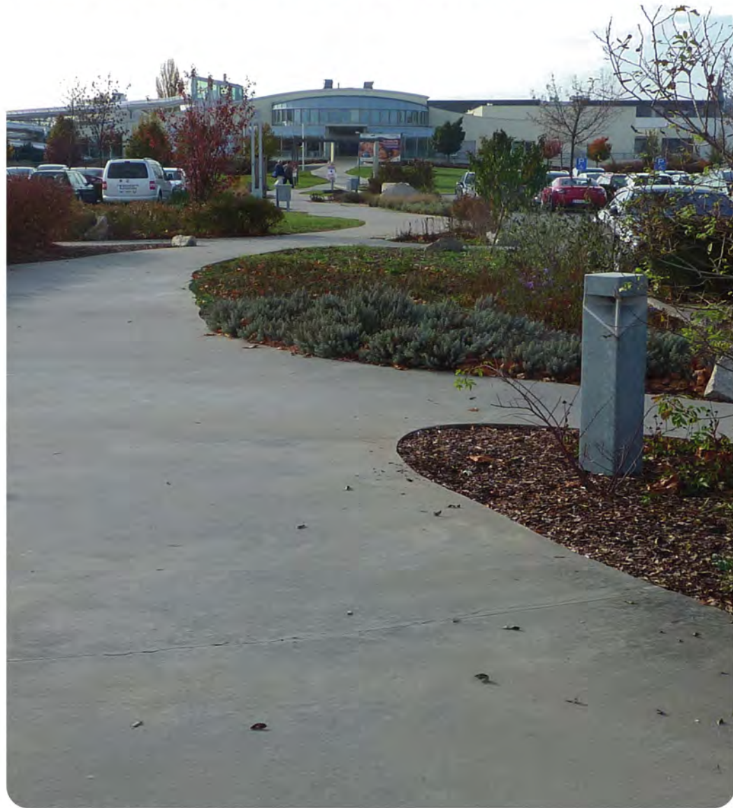
BETONOVÝ POVRCH CEST
