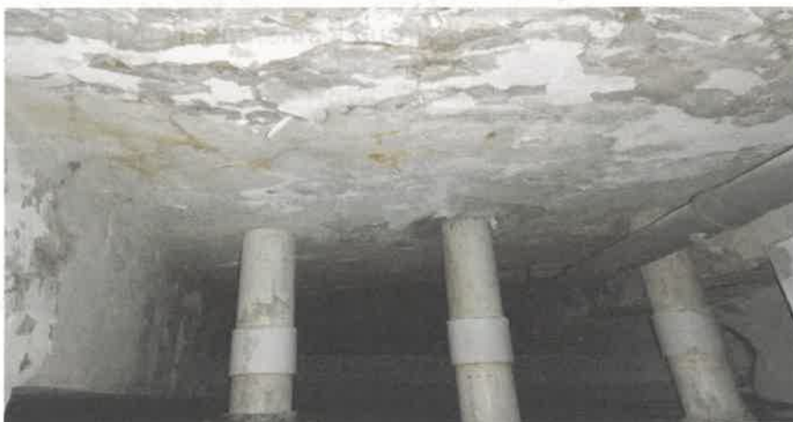
Obr. 7.10 – Detail stropu v suterénu v severovýchodní části
