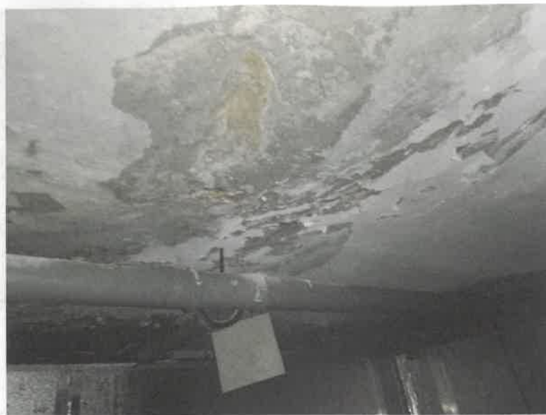
Obr. 7.7 – Detail stropu v suterénu v místě v SZ části
