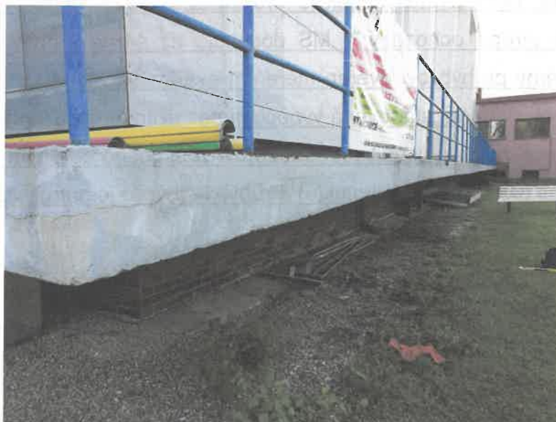
Obr. 7.1 – Pohled na balkón od severozápadu
