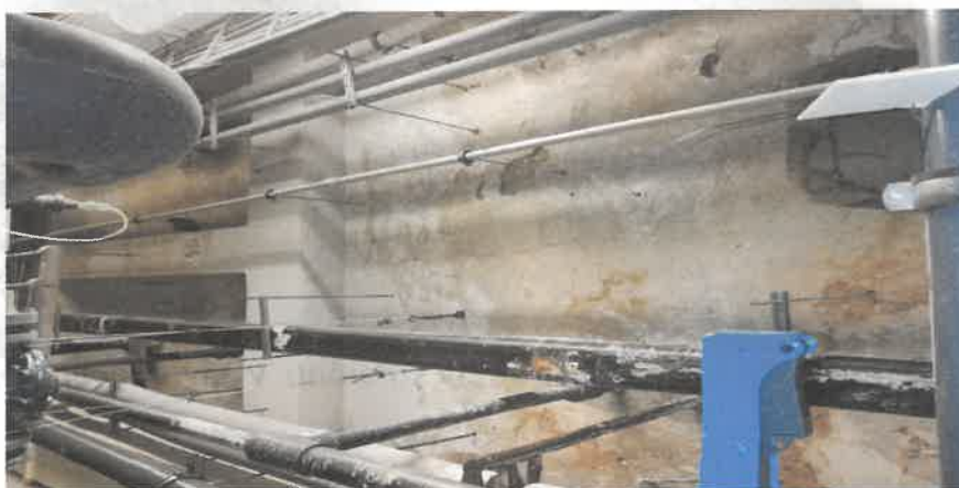
Obr. 7.8 – Strop v suterénu v jižní části
