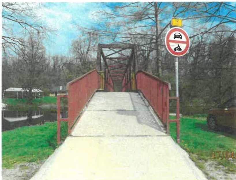
Podhled konstrukce nástupní rampy.
