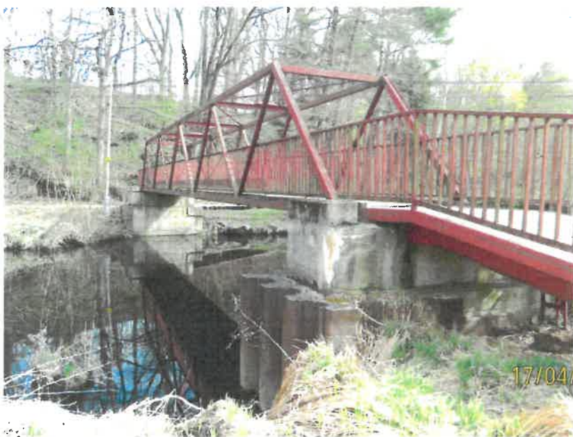
Pohled na lávku v oblasti mostovky.
