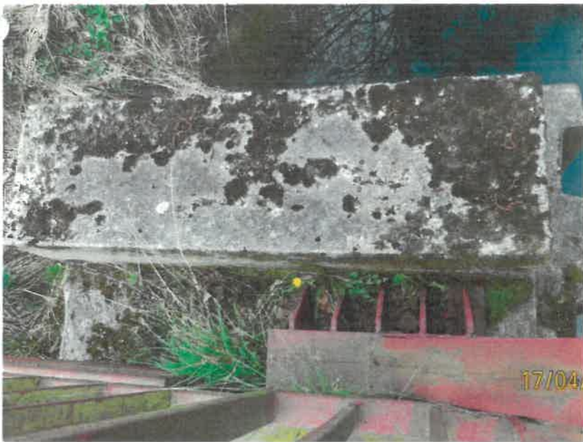
Hnilobou poškozený prvek mostovky.
