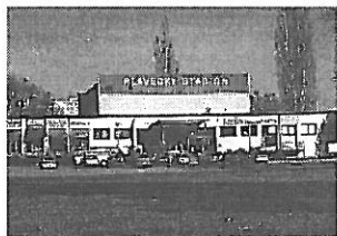
budova pl. stadionu
