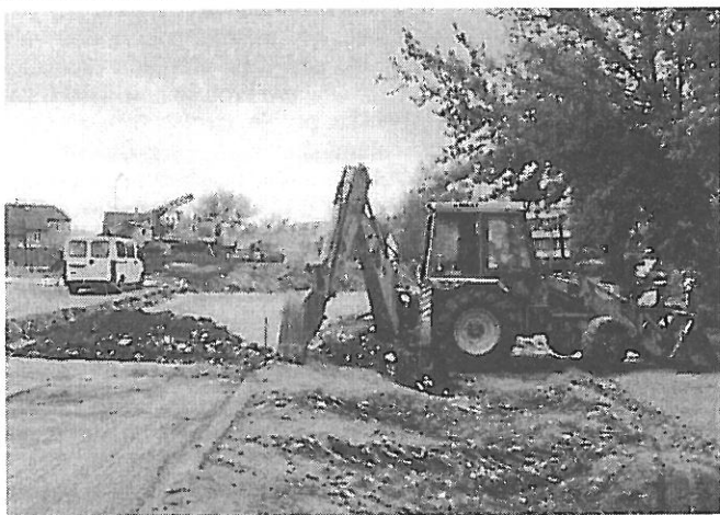
Práce na kruhové křižovatce skončily. Do provozu byl objezd uveden 26. června 2001 v 9.30 hod. dopoledne. Foto: Milan Kos
