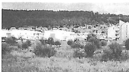
Po čtyřech letech výstavby byl 9. 7. v 10 hod. dopoledne slavnostně otevřen nový domov pro důchodce s kapacitou 120 lůžek. Foto: Milan Kos
