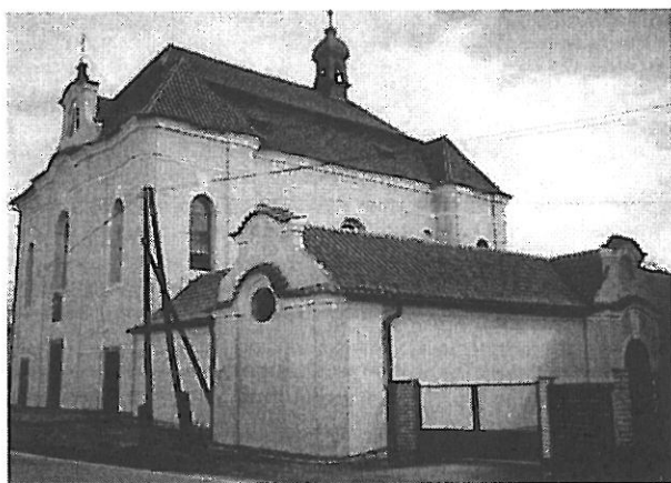
Dnešní stav kostela po rekonstrukci fasád počátkem 90. let.
