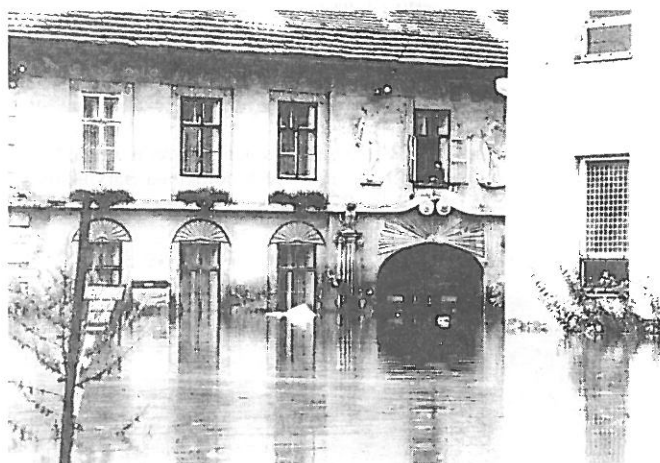
Přízemí klasicistního domu Na Ostrově se zaplnilo vodou stejně jako tovární haly.
