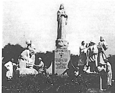
Poslední úpravy před dokončením sousoší (1926) Foto: archiv MSP
