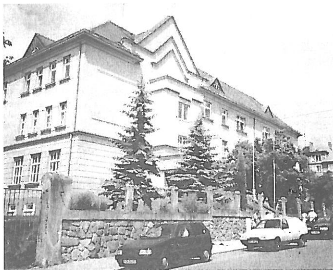
V roce 2002 probíhala výměna oken ve druhém nadzemním podlaží ve Zvláštní škole Plánkova. Foto: archiv MěÚ
