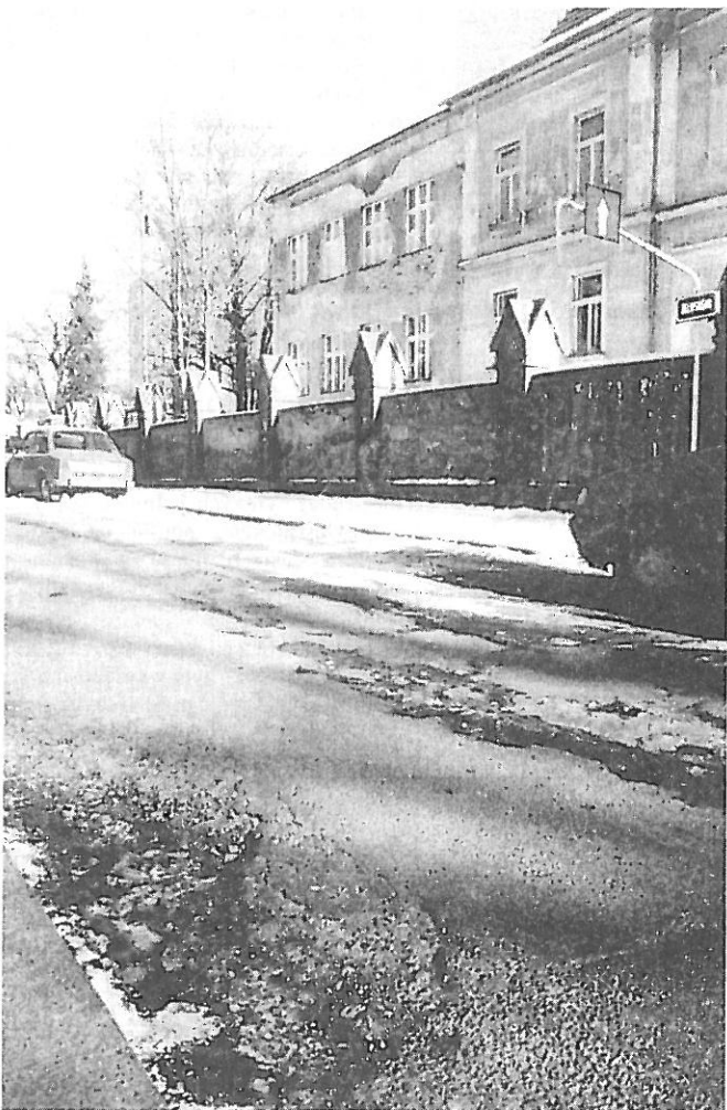
Takto zuboženě vypadala komunikace Želivského před právě probíhající rekonstrukcí. Foto: Milan Kos
