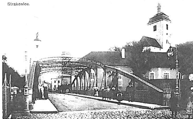
Obloukový železný most přes řeku Otavu.
