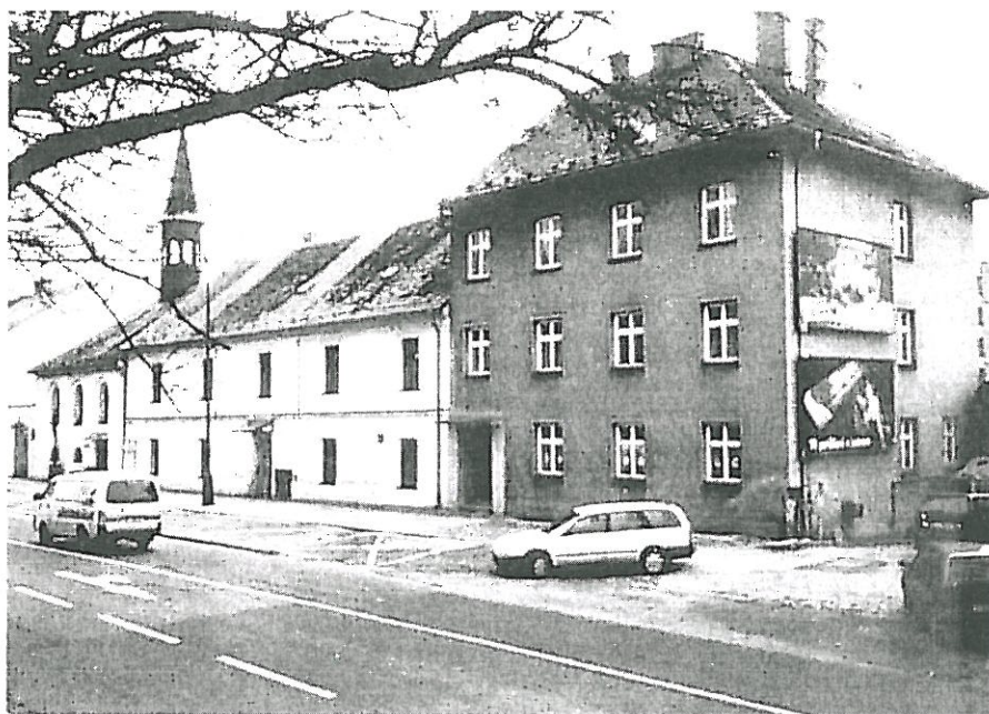
Rekonstrukce domova důchodců v Lidické ulici bude jednou z nejvýznamnějších akcí roku 2004.
