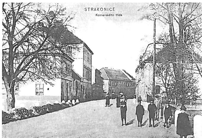
Pohled na Komenského ulici z roku 1909, velká budova vlevo – Komenského škola (v tehdejších Nových Strakonicih).
