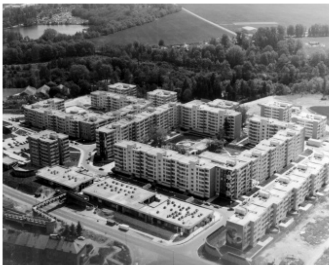
Pohled na sídliště Mír.
