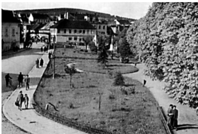
Idylická zákoutí starého mostu nahradilo v sedmdesátých letech necitlivě přemostění.
