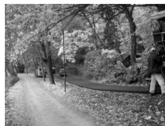
Stavba cyklostezky na Podskalí.
