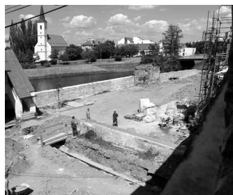
Na břehu Otavy na III. hradním nádvoří vzniká nová hradební zeď.
