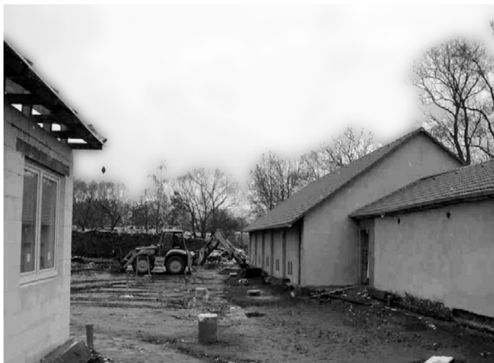
Budovy před dokončením.
