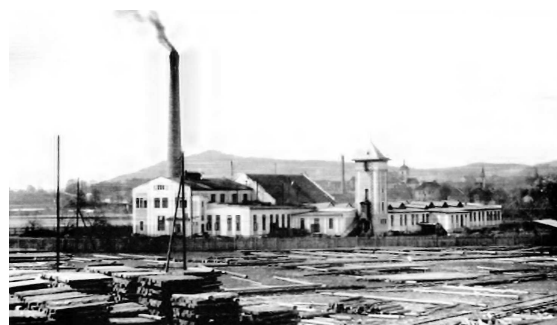
Zásoby dřeva a pražců na vlečce Pošumavských závodů pro impregnaci dřeva, vřadu Jihočeská zbrojovka.
