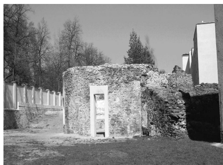
Hradební zeď s baštou. Foto: Archiv MěÚ
