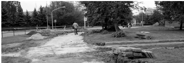
Budování cyklostezky navazující na cyklostezku okolo restaurace Jiskra a směřující k ulici Na Ohradě. Foto: Archiv MěÚ
