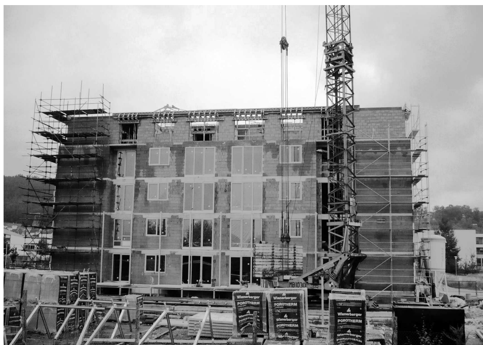
Stavba nového bytového domu.
