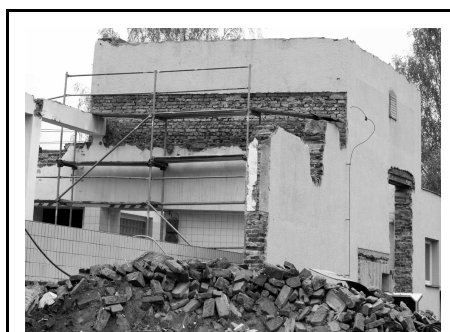
Dalším z důležitých projektů města Strakonice je rekonstrukce a modernizace úpravní vody v Hajské. Na realizaci díla se městu podařilo získat dotaci z rozpočtu Ministerstva zemědělství ČR a stavbu rovněž částečně dotuje i Jihočeský kraj. Podrobnosti k projektu najdete na www.strakonice.eu v rubrice Projekty města.
