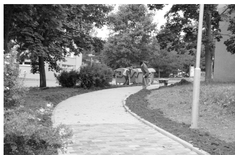
Poslední stavební úpravy na Sídlišti 1. máje.
