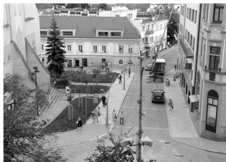
První fáze rekonstrukce je ukončena.
