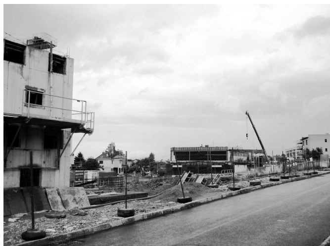
Stavba I. pavilonu.
