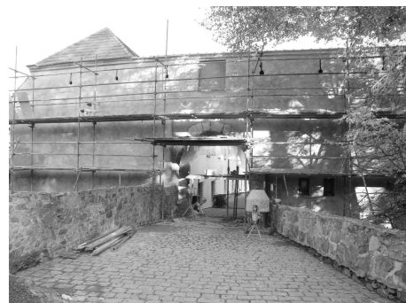
Oprava západní brány. Foto: Archiv MěÚ
