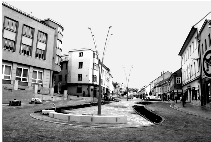
Pohled na rekonstrukci Velkého náměstí.
