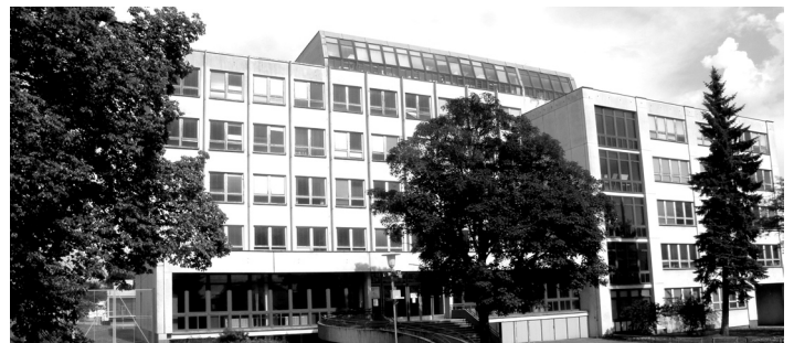
Budova průmyslové školy.
