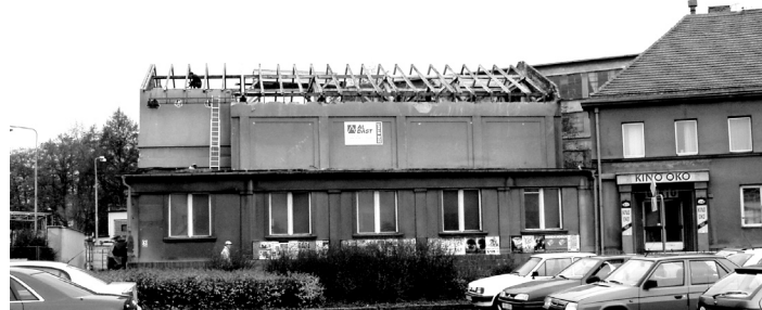
Demolice kina Oko po povodních v roce 2002.
