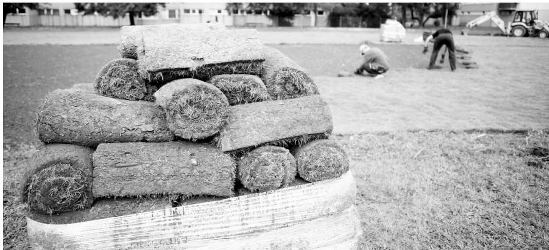
Pokládka travnatého koberce u ZŠ Dukelská.
