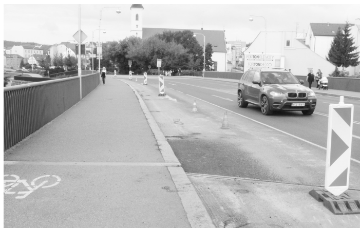
Koncem srpna byl na mostě Jana Palacha provizorně opraven asfaltový povrch. Foto: I. Malotová, archiv MěÚ
