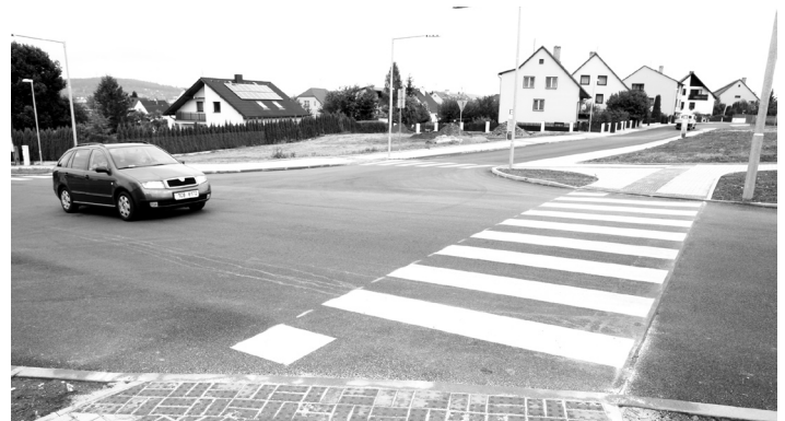
Zvýšení bezpečnosti dětí při pohybu kolem školy bylo cílem úprav komunikací v ulicích Povážská, Nad Školou a Hraniční v jižní části Strakonice.
