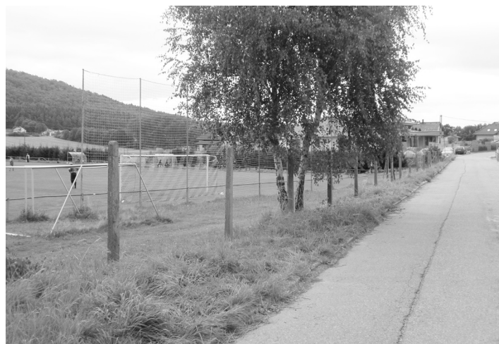
Fotbalové hřiště v Dražejově získá nové oplocení směrem k ulici Na Hrázi.
