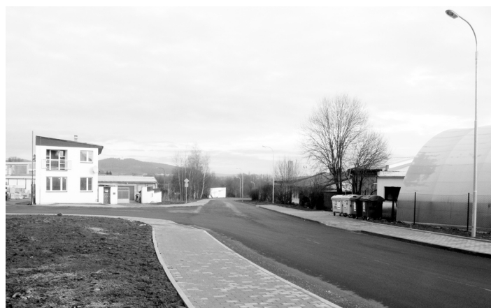
Nové komunikace v průmyslové zóně Na Jelence umožní její lepší využití. Letos by zde měla začít stavět nová závody firma Denios.
