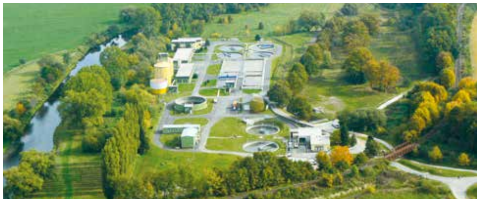
Čistiřna odpadních vod
