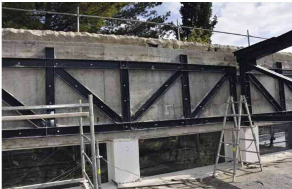
Ocelové výztuže atik
