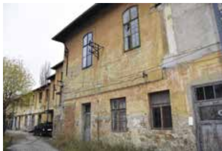
Původní objekt se začíná měnit v komunitní centrum foto: Markéta Bučoková
